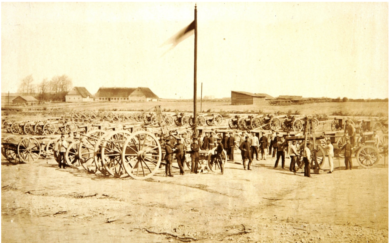
Belejringsparken på Nybøl Vestermark. I forgrunden 12 pd. riflede bagladekanoner og længst til venstre i mellemgrunden 12 pd. glatløbende forladekanoner. Bag disse ses en række 25 pd. morterer og i baggrunden tilhøjre nogle 24 pd. riflede bagladekanoner. Gården i baggrunden er Rundkær. Foto: Heinrich Graf. (4598)
