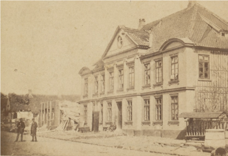
Wilhelm Schrøder/Georg E. Hansen: Løve-Apoteket, Perlegade 4 var ikke mere beskadiget end det lod sig reparere. Derimod var de følgende ejendomme nr. 6 (apoteker Paulsen), nr. 8 (dr. Nagel), 10 (gæstgiver Stentoft) og nr. 12 (snedker Andresen) næsten totalt ødelagte. Bemærk skilderhuset som er blevet efterladt ved det tidligere hovedkvarter. (6143)
